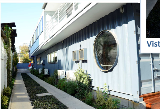
Vista Lateral del Edificio
